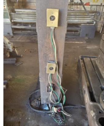
Fig. 5. malas condiciones eléctricas y de delimitación de áreas
